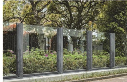
図13 ガラススクリーン止水板
