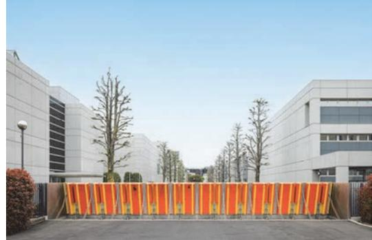
図12 浮力起伏式止水板
