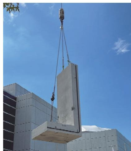
図14 CO<sub>2</sub>-SUICOM 止水壁
