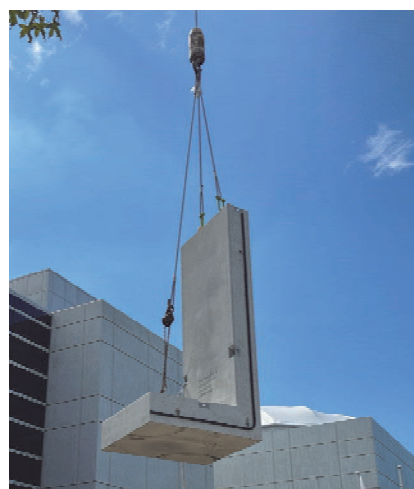
図14 CO 2 -SUICOM 止水壁
