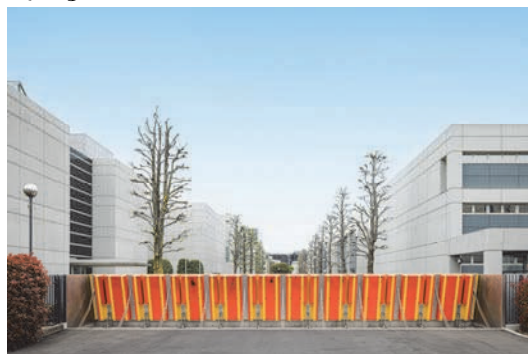
図12 浮力起伏式止水板
