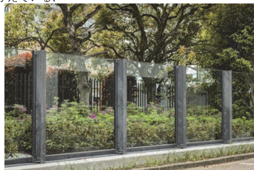
図13 ガラススクリーン止水板
