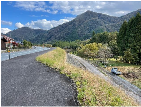
写真1 地区全体嵩上げの様子（美郷町）
