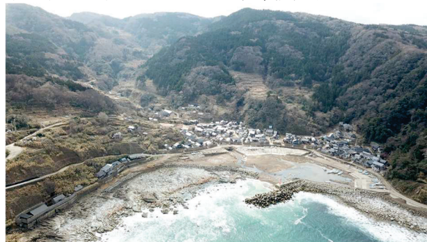
図3 豪雨災害後の土砂が堆積した漁港と崖が崩れた集落（写真：2025年3月撮影）
