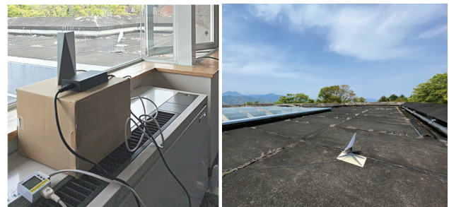
図3 機器の設置状況
