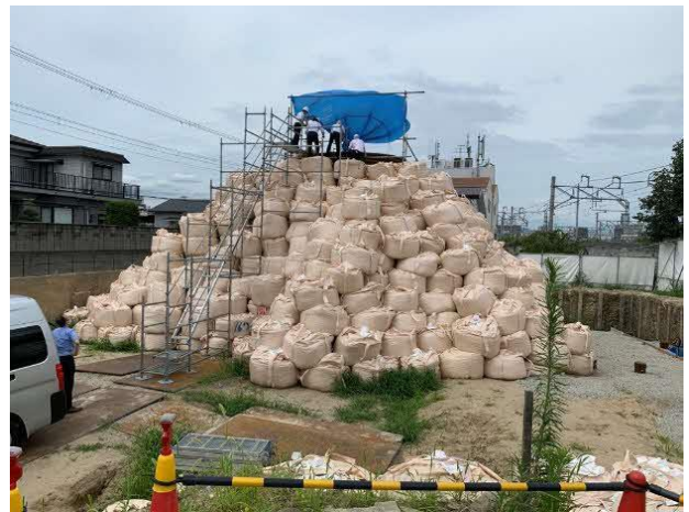
写真1 吹田市において設置された処理壕
