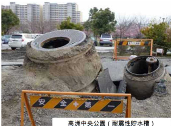
写真1 液状化の被害を受けた埋設式耐震性貯水槽
