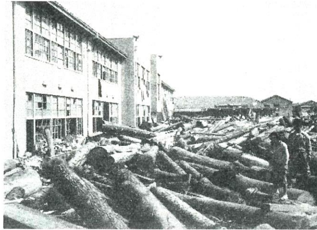
図4：貯木場から流出した木材に埋まる白水小学校分校校庭（参考文献2より引用）
