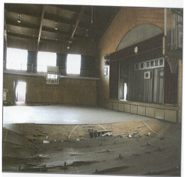
図2 請戸小学校の体育館の様子
