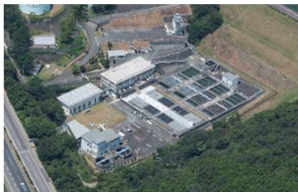
図3 愛知県豊川浄水場
