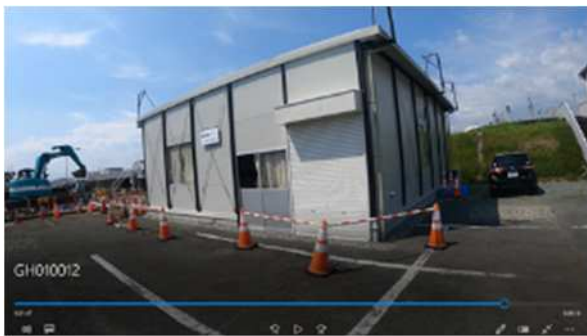
図 9 映像資料（膜ろ過実験棟）
