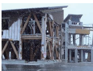
写真3 被災した北上総合支所
