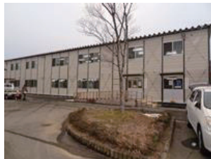
写真4 プレハブ仮設庁舎
