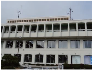
写真7 管内で唯一残った公共施設(牡鹿総合支所)
