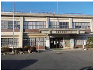
写真9 河南総合支所
