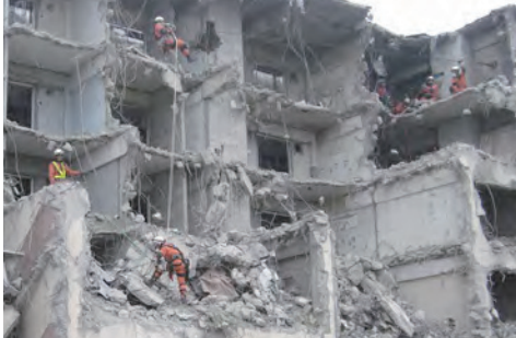
写真 2： 解体工事途中の建物を使用した訓練例（県外事例）
