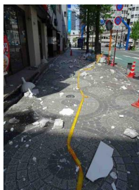
写真 熊本市内における壁面部材の落下の状況
