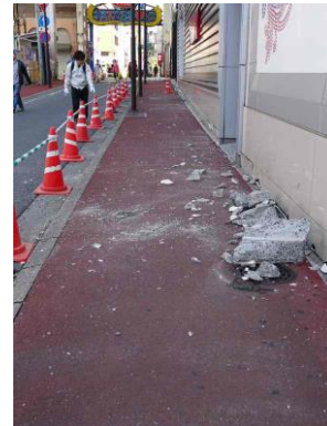
写真 熊本市内における壁面部材の落下の状況
