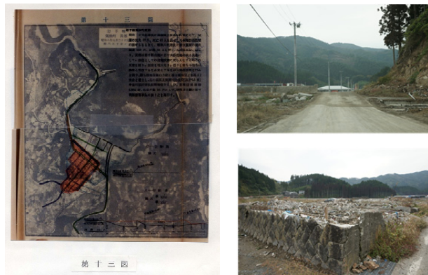
図3 長部地区（陸前高田）の移転地と被害（上：防潮堤，下：盛土）
