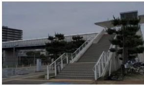
歩道橋と階段
