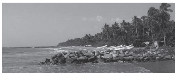
図 4 Kalutara—Maggona 堤防・護岸設備の例
