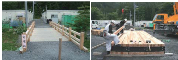
写真5 仮設の木製歩道橋 写真6 人力による組立
