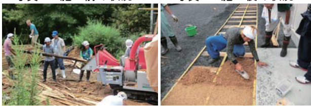
写真3 ウッドチップの製造 写真4 チップ舗装の施工
