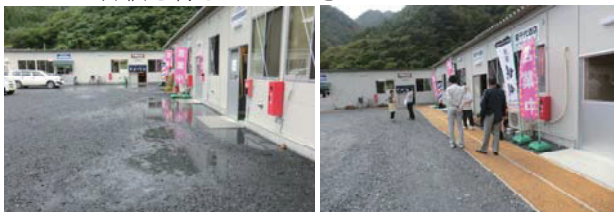
写真1 施工前の状況
