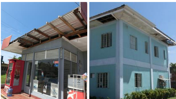
図 4 セブ島の半壊建造物 (屋根が破損したメデリン内の建造物)
