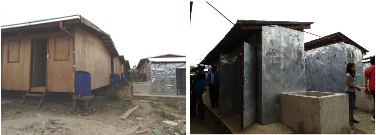
図10 仮設住宅の設備 (左:雨水を回収する貯水タンク, 左:トイレ)
