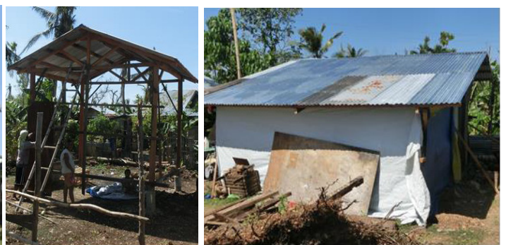
図 6 カウイットの復興住宅 (壁面の素材はブルーシート、木板、竹等を使用)
