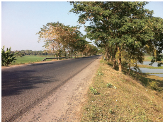
図 3 浸水しないよう嵩上げされた低平地の道路
