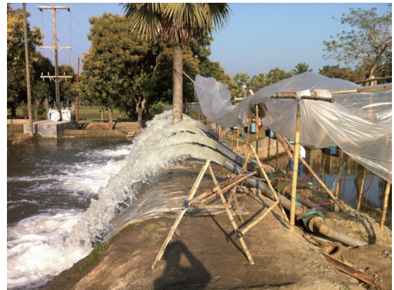
図 5 塩水を排出するポンプ
