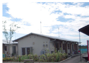
写真1 木造仮設住宅
