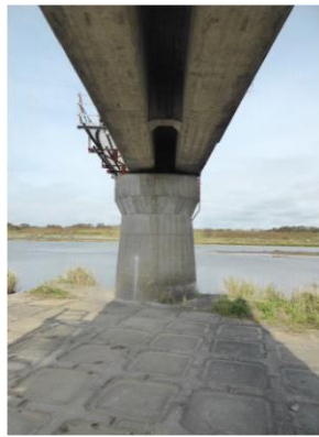
(g) 日高本線の橋梁桁ずれ(厚真川河口部)
