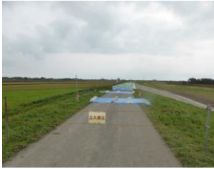
(h) 鶴川左岸堤防応急復旧工事及び天端シート張り状況
