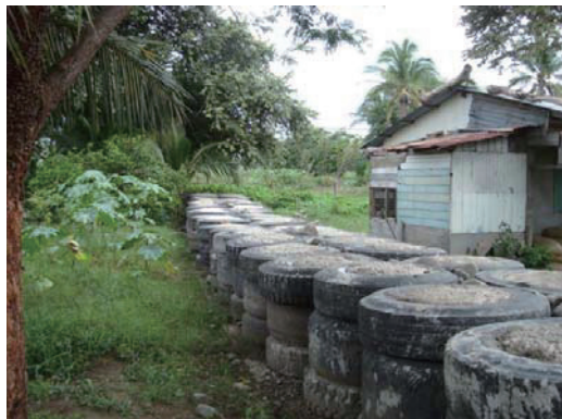
写真3 古タイヤ堤防 (ホテル地区)
