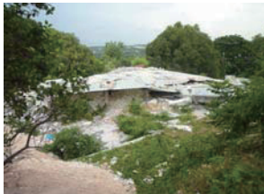
丘陵地における建物被害
