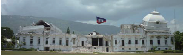
中心市街地における National Palace の被害
