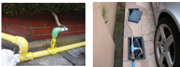
写真 1 仮配管による各家庭への上水道供給
