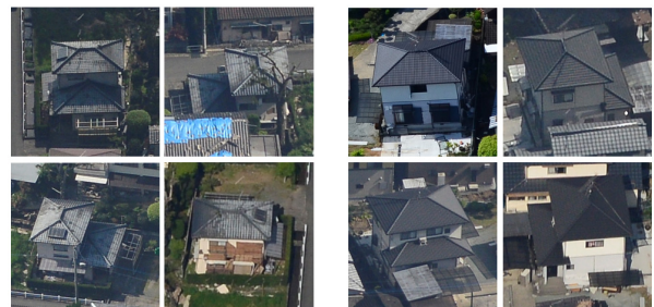
図1 4方向から見た建物被害の一例
