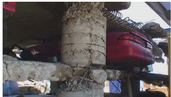
写真4 : パンケーキクラッシュした駐車場想定施設の例
