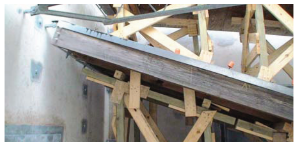
写真5 : 天井の傾斜角を容易に変更するための金具の工夫
