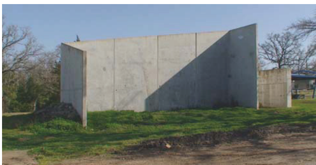
写真3 : Exterior Shoring 基礎訓練用施設
