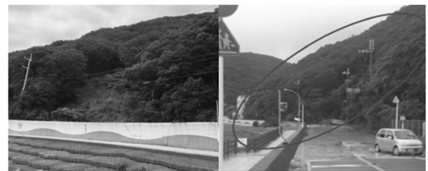
図3 左図：被災箇所②の表層崩壊法面(災害復旧工事後)、右図：被災箇所②の被災直後の状況
