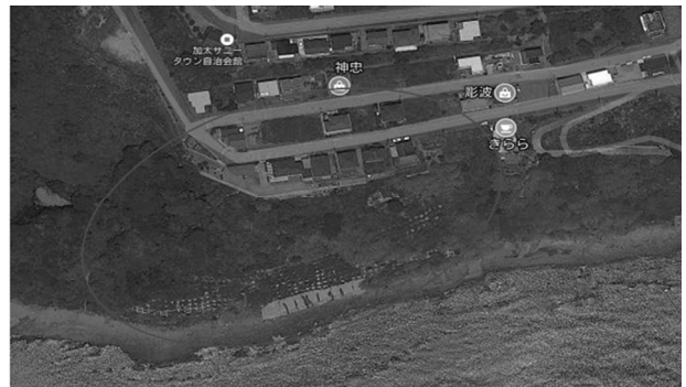
図2 地すべり対策工事が行われた市道と法面
