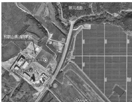
図5 被災箇所③の周辺状況
