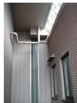
写真 1 山形県立中央病院の外観写真 写真 2 免震病棟と耐震病棟のジョイント部
