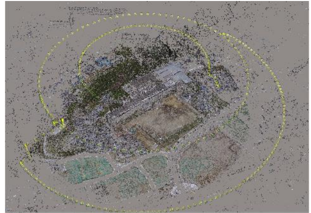
図 10 旧門脇小学校 空撮地点と点群データ
