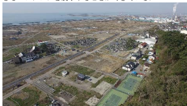
図 5 UAV による空撮映像 (被災区域の広がり)
