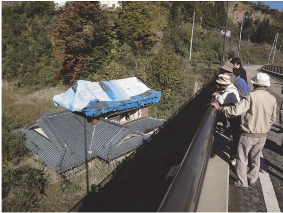
図5 水没家屋(平成23年11月撮影)
