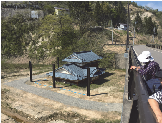
図6 補修された家屋(平成29年5月撮影)
