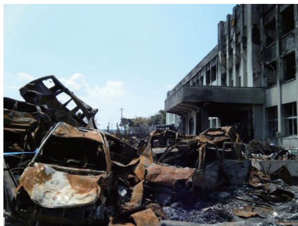
写真2 門脇小学校と焼損した自動車(4月28日撮影)
