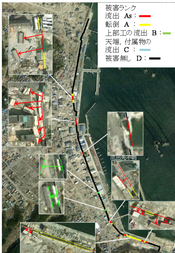
図4 分析対象とする防潮堤の被害及び無被害の詳細
