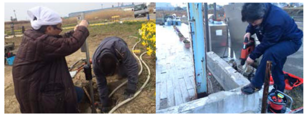
図4 赤外線センサーの固定および配線の埋設
