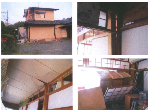
図15 住民が撮影した前震後の被災建物（表14のB5建物）
