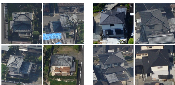
図3 4方向から見た建物被害の一例 15), 16)
