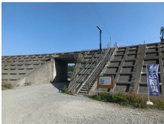
防潮堤の地面からの高さは5mほどあるが(左下)、津波はこれを乗り越え防潮堤の内側にも被害を及ぼしており、かつての住宅は残っていない(右下)
