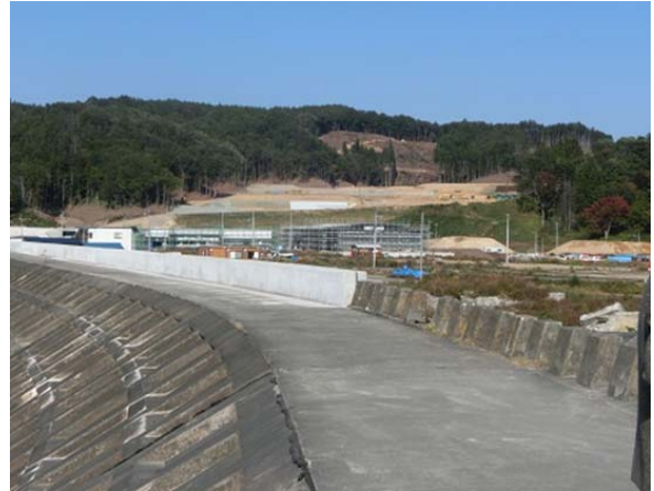
右上：防潮堤から見た開発中の高台移転地
