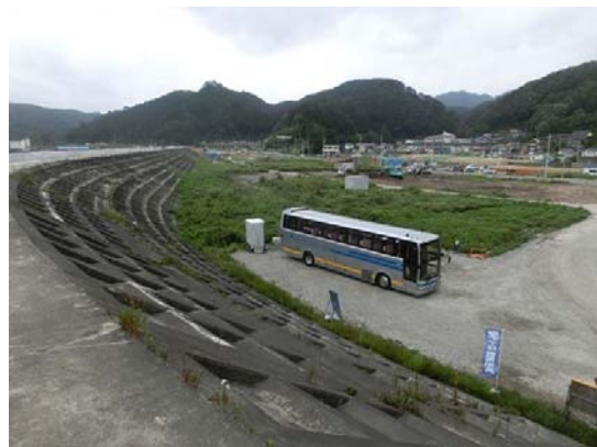
防潮堤の地面からの高さは5mほどあるが(左下)、津波はこれを乗り越え防潮堤の内側にも被害を及ぼしており、かつての住宅は残っていない(右下)
