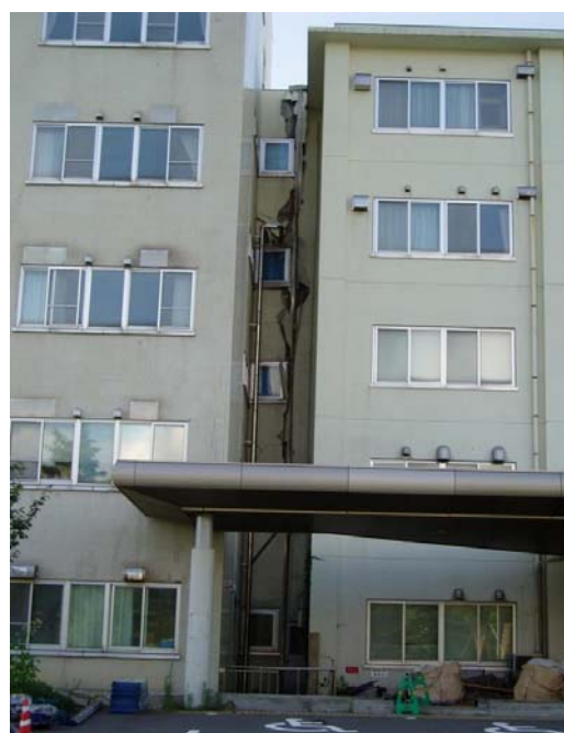
写真1 病院の渡り廊下の被害
