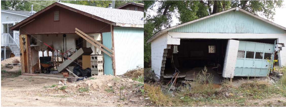
図 13 破壊されたりゆがんだりした住宅の一部
