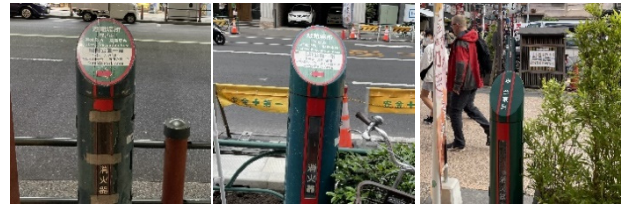
①避難誘導標識1 ②避難誘導標識2 ③消火器収納
