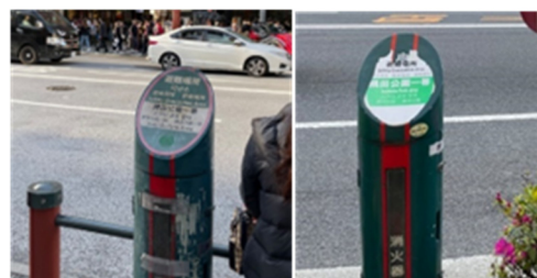
①方向矢印がない標識 ②シートが破損した標識
