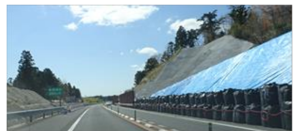
図4 常磐自動車道の切土斜面崩落位置（上）と4月10日撮影の現場の様子（下）
