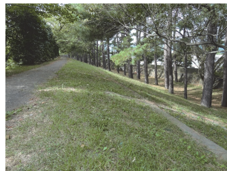
写真 1-1 広村堤防(和歌山県広川町)
