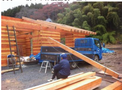
写真6 小屋組み施工
