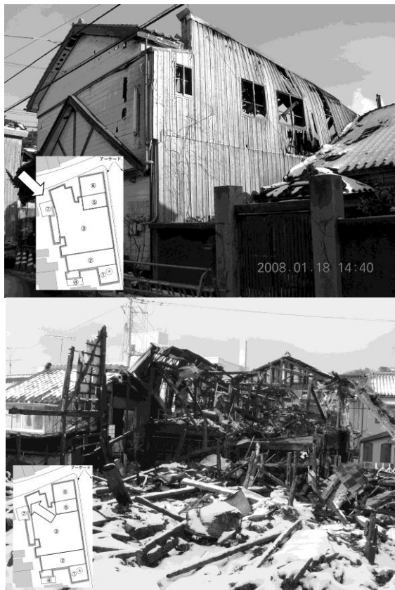
図2 ブロック外縁部の外壁が燃え残り、内部は原形をとどめていない状況。文献 7) から引用。
