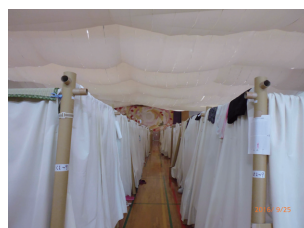
写真4) 天幕と紙管の間仕切り
