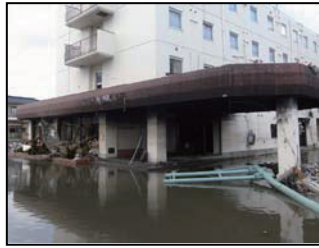
写真 6 燃えた津波避難ビル (2011 年 4 月 24 日筆者撮影)
