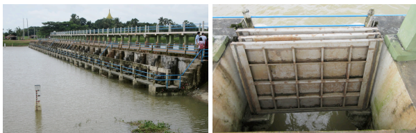
写真1(左) スルースゲート全景(水路反対側) 写真2(右) スルースゲート角落し式小ゲート(水路側)
