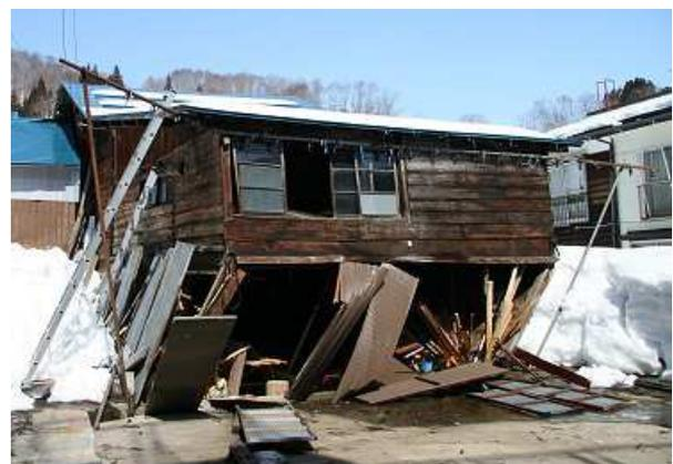
図 16 1 階部分が潰れる倒壊モードを示す被災事例
