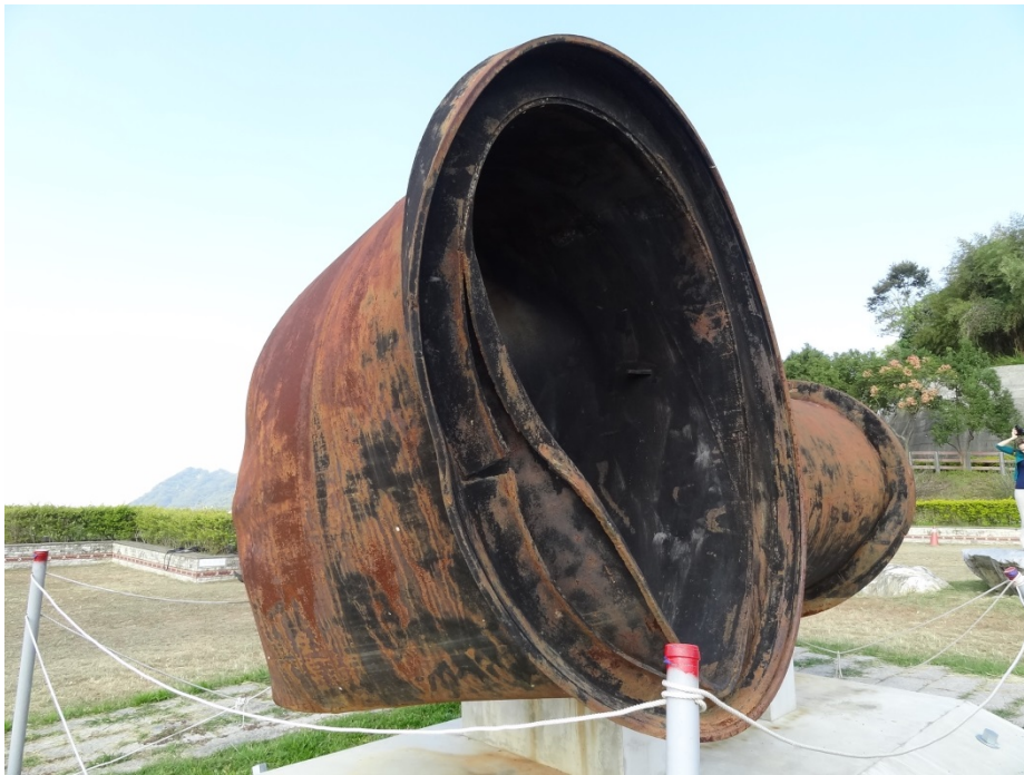
図 2-7 地震の衝撃で折れ曲がった水道管
