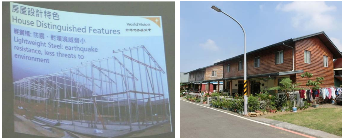
図 3-2 ネ豊納里集落 恒久住宅内部構造 (2) および外見（二戸建住宅）
