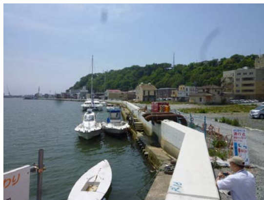
写真5 旧河川堤防が嵩上げされるとともに数 100m 毎に設置される排水ポンプ
