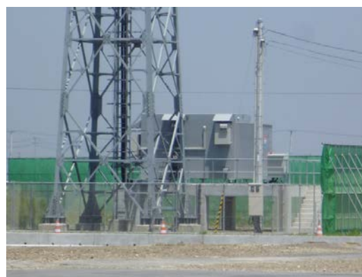
写真2 通信タワーのユニットの高所配置 (仙台市)
