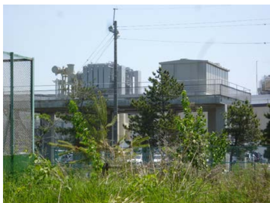
写真1 民間の電力設備の高所配置 (仙台市)
