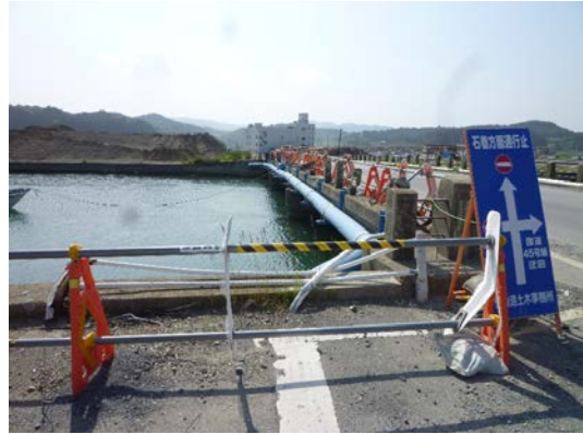
写真4 大潮の満潮時で道路橋の橋脚梁部下まで水位が達している。
