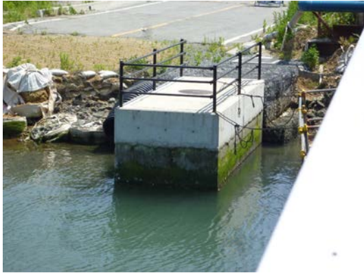
写真3 津波で河川盛土が浸食された通信マンホールが嵩上げされている（南三陸町）
