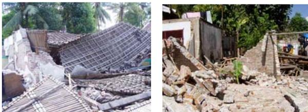
写真1 種々の材料によるノンエンジニアド住宅の地震被害
