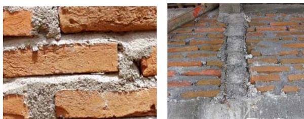
写真5 インドネシアのノンエンジニアド住宅の施工状況
