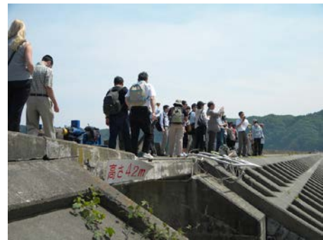
宮古市田老地区の防潮堤で職員の解説を聞く参加者（6月20日 写真 小林郁雄）
