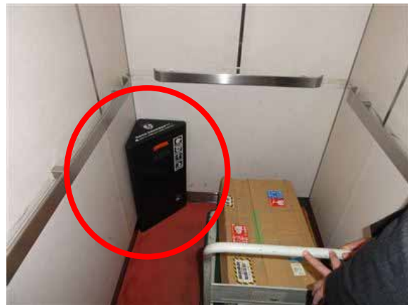
写真1 設置された防災備蓄ボックス
