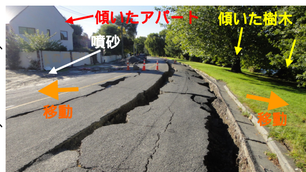
写真-5 Avonside Dr. の側方流動 (堤防道路に縦亀裂、両側に拡大 2011.3.7)
