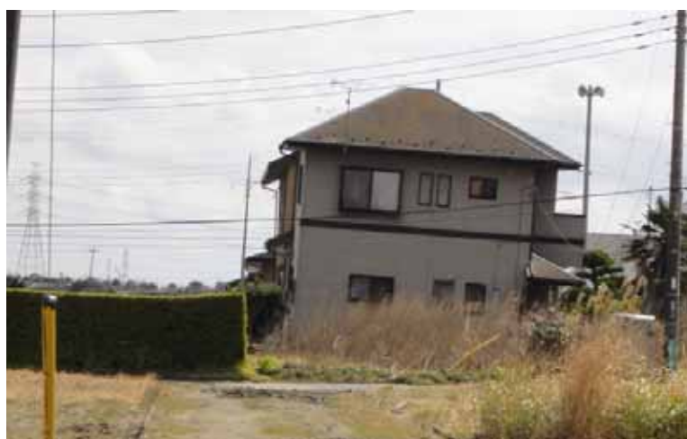
写真-6 潮来市日の出地区での住宅造成地での液状化被害(3月23日)。家屋の傾斜が大きい(4度)
