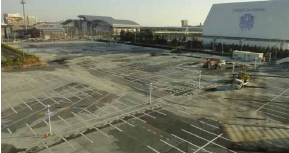
写真-4 浦安市舞浜の東京ディズニーランドの駐車場ででの液状化の様子(3月13日(日))。噴砂除去作業も終盤。
