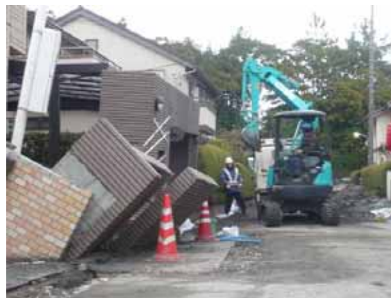
千葉県浦安市の液状化被害
