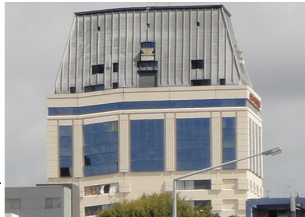
写真-3 Hotel Grand Chancellor の被害 (2011.3.6)
