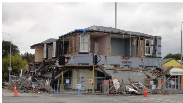
写真-1 古い2階建レンガ造建物の被害 (2011.3.7)
