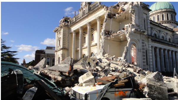
写真-2 カトリック大聖堂の被害 (2011.3.6)
