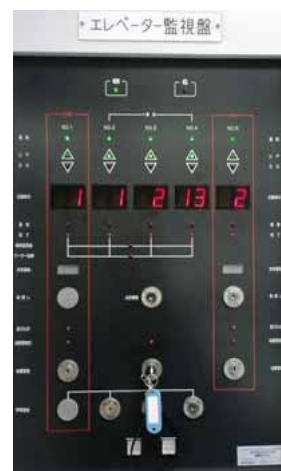
写真6 エレベーター制御盤
