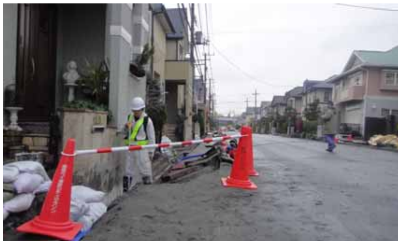
写真-5 浦安市舞浜3丁目の住宅造成地での液状化(3月21日)。左側の家は道路より70cm沈下、右側の家は道路と反対の方向に傾斜しており、噴砂は片付けられていた。
