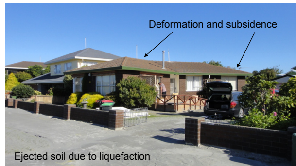
写真-8 液状化と側方流動で被害を受けた家屋 (Hulverstone Drive, 地震保険加入)
